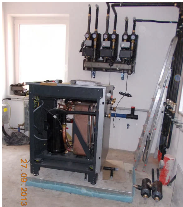
Foto: während des Einbaus (noch nicht vollständig installiert)
